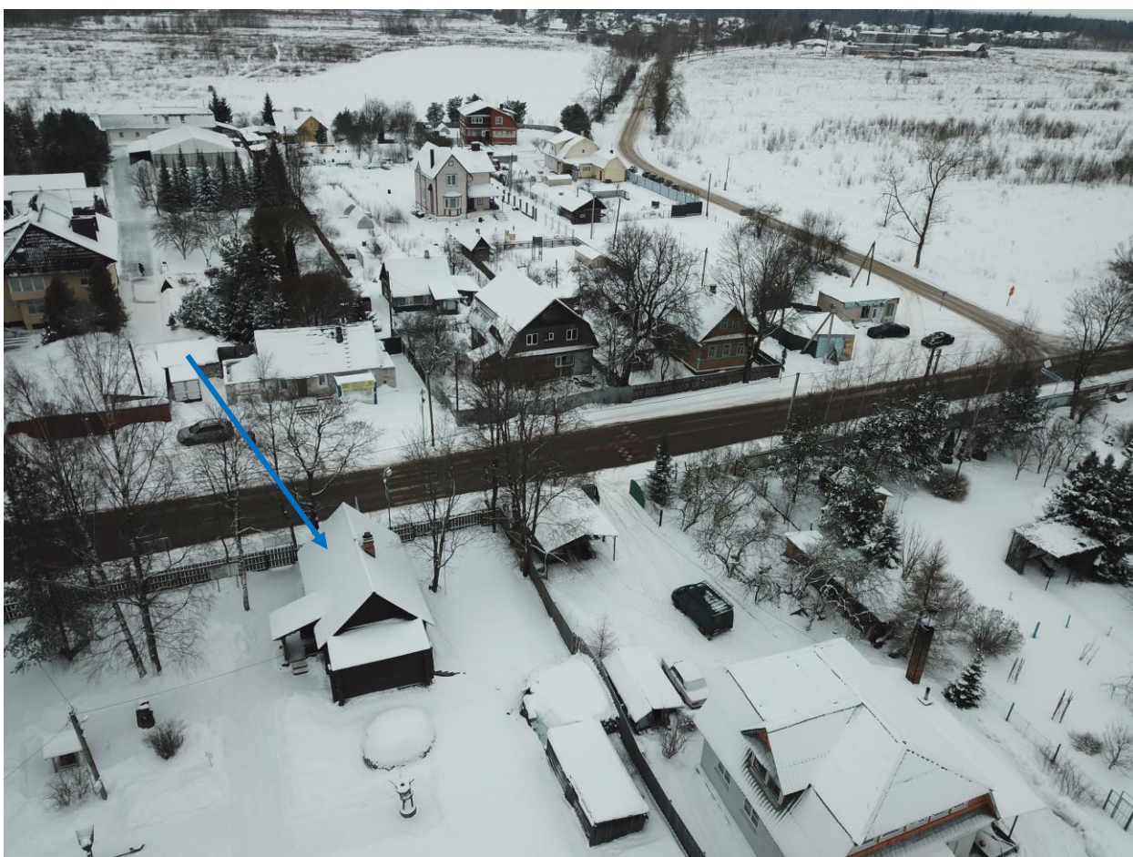
Фото 2. Вид на объект культурного наследия регионального значения «Дом, где бывала няня А.С. Пушкина - Арина Родионовна» по адресу: Ленинградская область, Гатчинский муниципальный район, Кобринское сельское поселение, деревня Кобрино, дом 27 и на территорию деревни сверху. Объект обозначен на фото голубой стрелкой.
