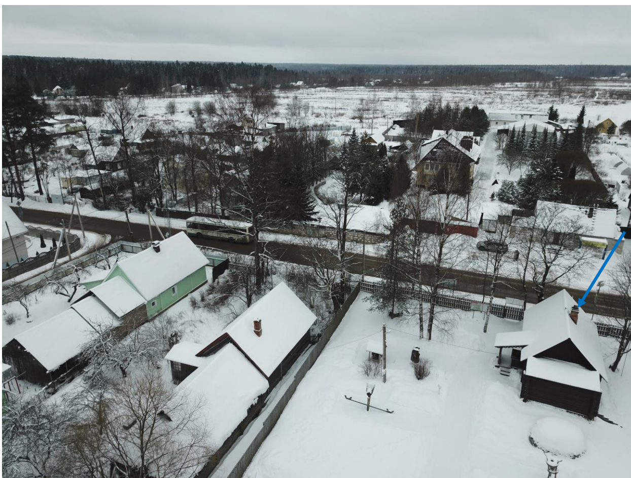
Фото 3. Вид на объект культурного наследия регионального значения «Дом, где бывала няня А.С. Пушкина - Арина Родионовна» по адресу: Ленинградская область, Гатчинский муниципальный район, Кобринское сельское поселение, деревня Кобрино, дом 27 и на территорию деревни сверху. Объект обозначен на фото голубой стрелкой.
