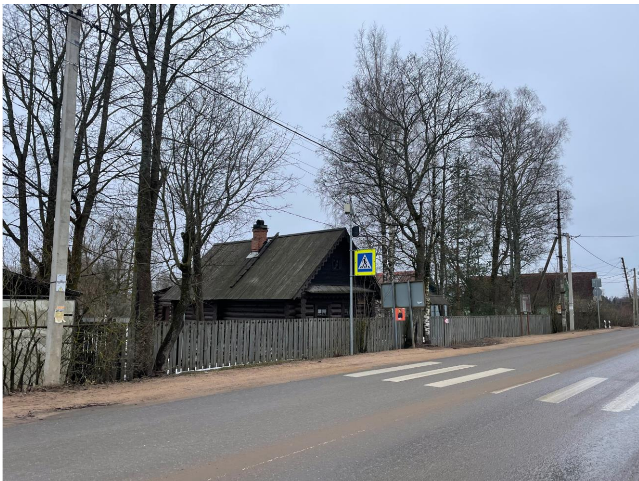
Фото 4. Объект культурного наследия регионального значения «Дом, где бывала няня А.С. Пушкина – Арина Родионовна». Вид с запада, с дороги
