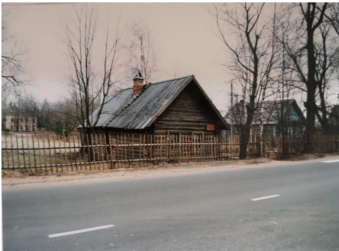
Илл. 35. Деревня Кобрино, дом 27. ОКН «Дом, где бывала няня А.С. Пушкина - Арина Родионовна». Фото 2001 г. // Фотофиксация в процессе авторского надзора. ГП СПбНИИНИ "СПР". 2002 г. (Проект ремонта и консервации дома НИИ СПР. 1999 г.). Архив комитета по сохранению культурного наследия Ленинградской области. №п/п 8165. № дела 461-13.
