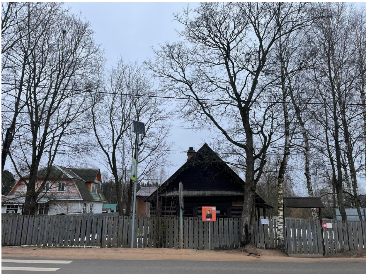
Фото 1. Объект культурного наследия регионального значения «Дом, где бывала няня А.С. Пушкина – Арина Родионовна». Вид с запада, с дороги.
