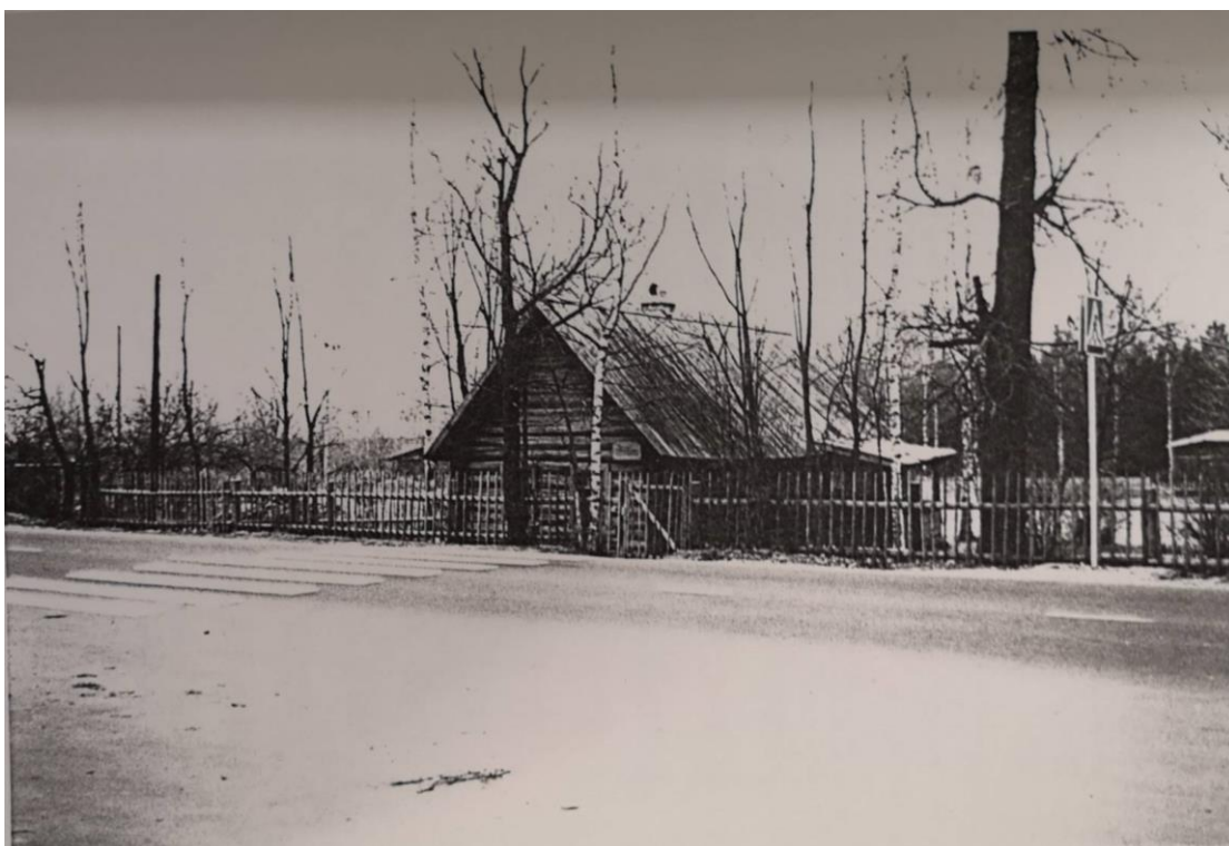
Илл. 33. Деревня Кобрино, дом 27. ОКН «Дом, где бывала няня А.С. Пушкина - Арина Родионовна». Фото 1999 г./Проект ремонта и консервации дома НИИ СПР. 1999 г. Архив комитета по сохранению культурного наследия Ленинградской области. №п/п 7417. № дела 461-12.
