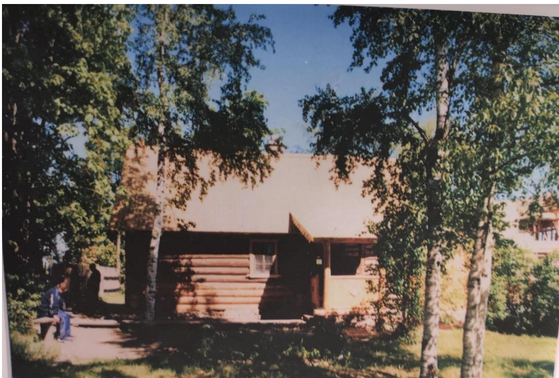
Илл. 39. Деревня Кобринно, дом 27. ОКН «Дом, где бывала няня А.С. Пушкина - Арина Родионовна». Фото 2002 г.// Фотофиксация в процессе авторского надзора. ГП СПбНИИНИ "СПР". 2002 г. (Проект ремонта и консервации дома НИИ СПР. 1999 г.). Архив комитета по сохранению культурного наследия Ленинградской области. №п/п 8165. № дела 461-13.
